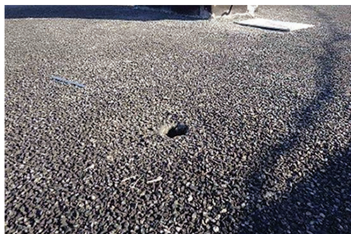
Drain de toit sans grille
