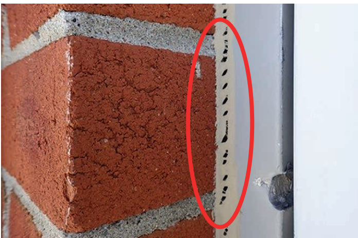
Calfeutrage fissuré/desséché
