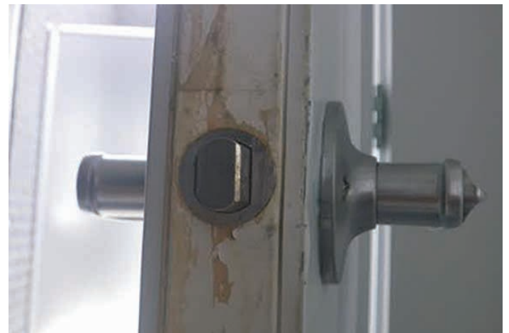
Usure suggérant un mauvais ajustement de la porte
