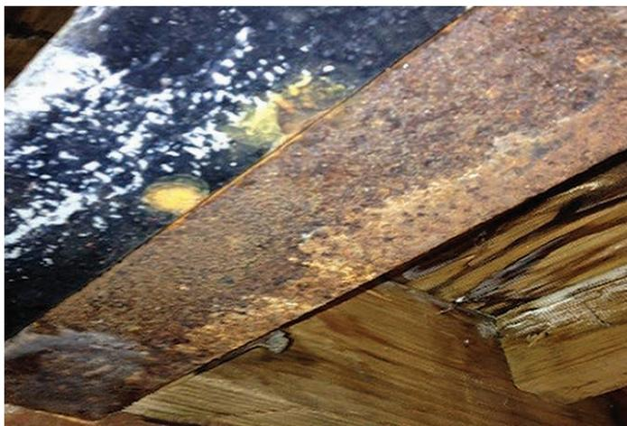
*Structure d'acier endommagée sous un balcon*
