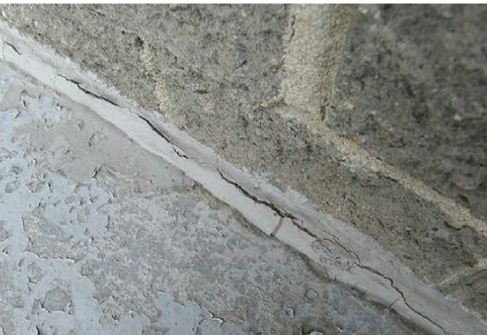
Calfeutrage fissuré/desséché
