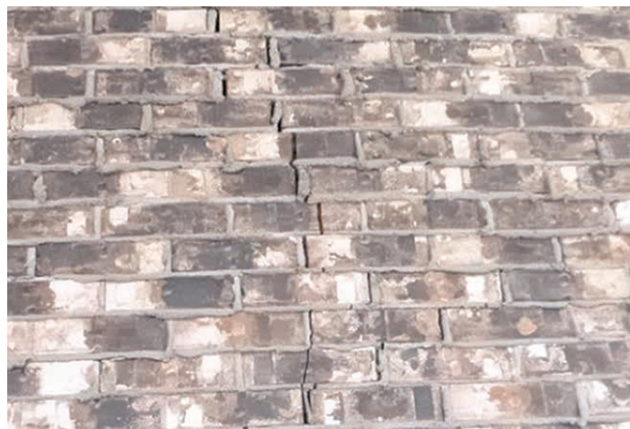
Parement/mortier fissuré
