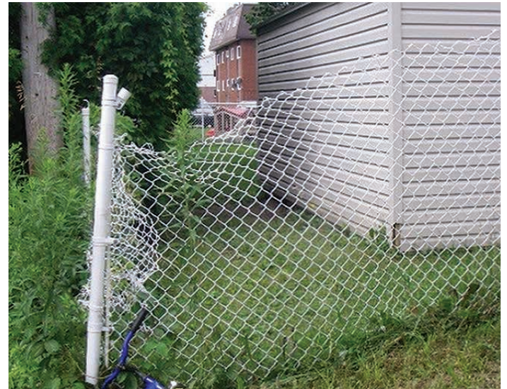
Clôture ayant subi un bris
